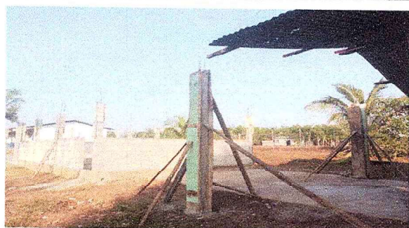
Foto1: En esta fotografía se divisa cuando los albañiles se estaban nivelando las alturas de cada columna de la cocina.
